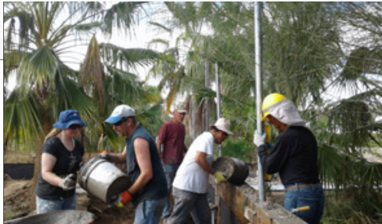
Crew members pour bond beam.
